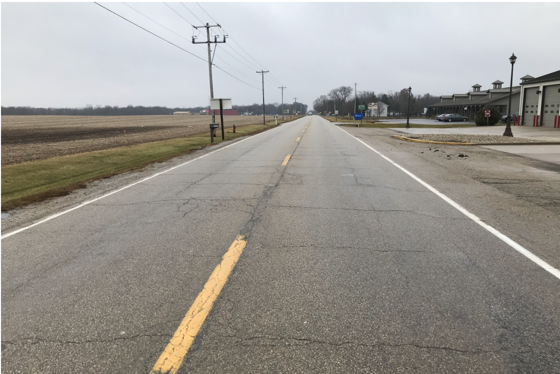
IL - 178 Looking South
