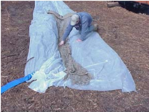
3) Lay jute matting
