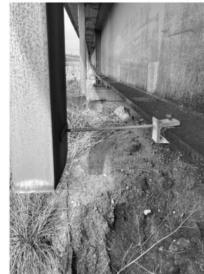
EXISTING FLANGE CLAMP (TYP.)
