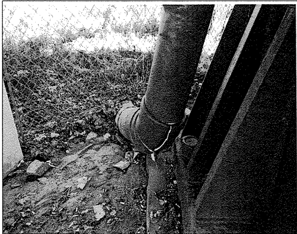
016-1067 PHOTO #1 PIER A4
