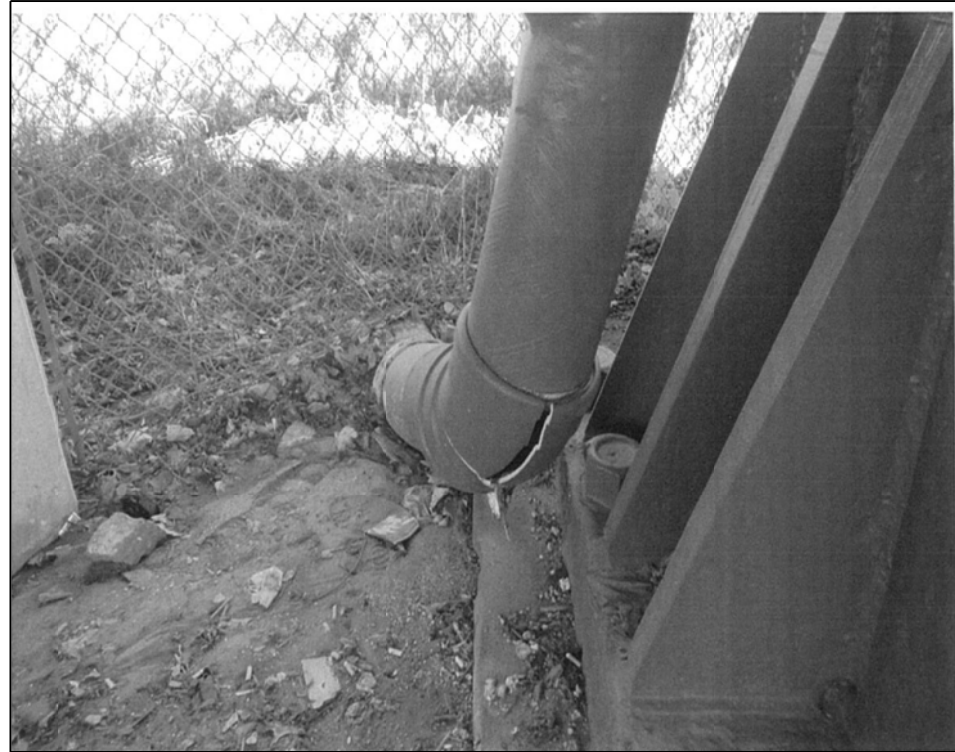
016-1067 PHOTO #1 PIER A4
